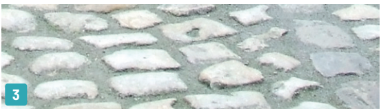
/ Rodzaje materiałów na nawierzchnie przepuszczalne: żwir o dużym uziarnieniu (1), kostka kamienna na podbudowie piaszkowo-żwirowej (2), bruk kamienny (3) // fot. Monika Domanowska, Fundacja Sendzimira
