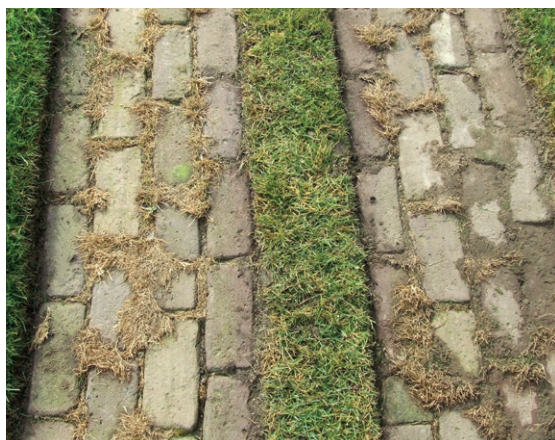
/ Nawierzchnia z cegły klinkierowej o podbudowie żwirowej // fot. Fundacja Sendzimira
