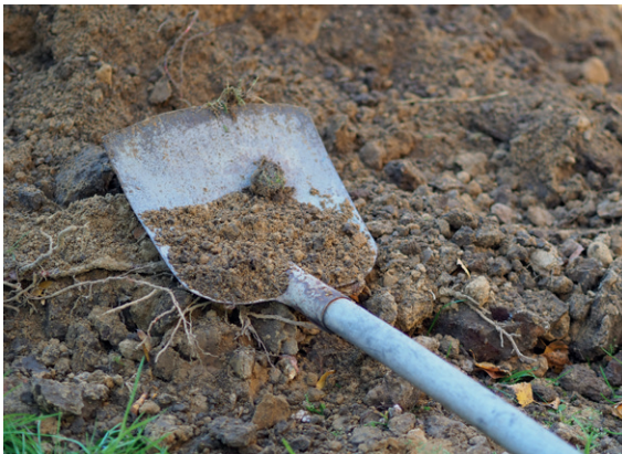
/ Przygotowanie wykopu pod nieckę // fot. Judyta Łuczyńska, Fundacja Sendzimira
