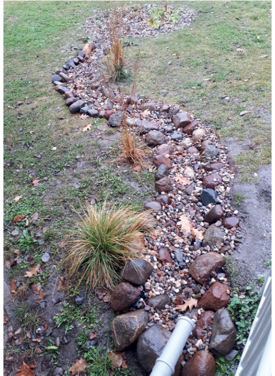
/ Doprowadzenie wody suchym potokiem // fot. Judyta Łuczyńska, Fundacja Sendzimira
