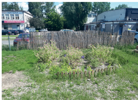
/ Niecka retencyjna w Warszawie // fot. Fundacja Sendzimira
