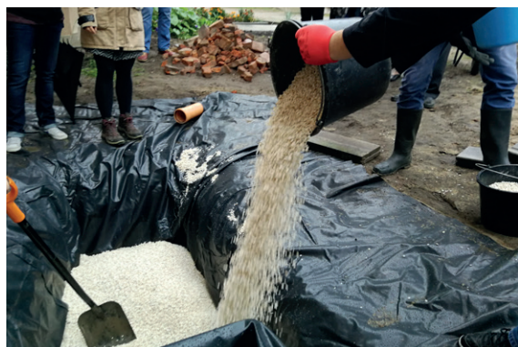
/ Budowa ogrodu deszczowego izolowanego folią w Olsztynie // fot. Katarzyna Biejat, Fundacja Sendzimira
