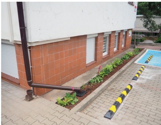
/ Przykładowe doprowadzenie wody do ogrodu deszczowego przy pomocy rury // fot. Fundacja Sendzimira
