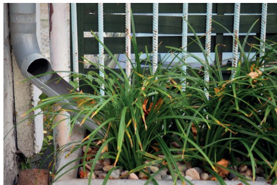
/ Ogród deszczowy w pojemniku przy Przedszkolu nr 43 we Wrocławiu // fot. Małgorzata Piszczek
