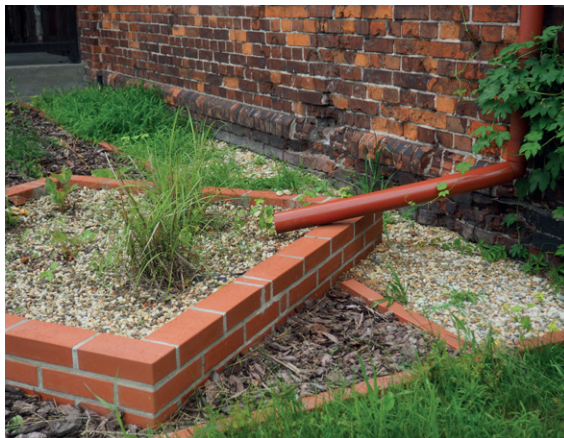
/ Doprowadzenie wody z dachu budynku do ogrodu // fot. Fundacja Sendzimira
